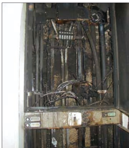
Obr. 3. Vyhořelá stoupací elektroinstalační šachta
