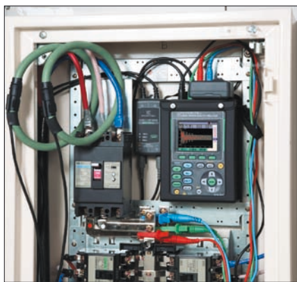
Obr. 5. Měření přístrojem KEW 6310 v rozváděči
