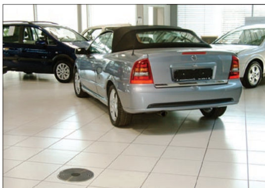
Obr. 1. Přístrojová jednotka OBO pro velké zátěže v podlaze autosalonu
