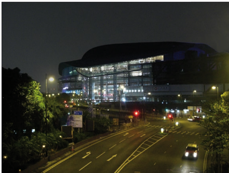
Obr. 2. Hlavní budova výstaviště HKTDC
