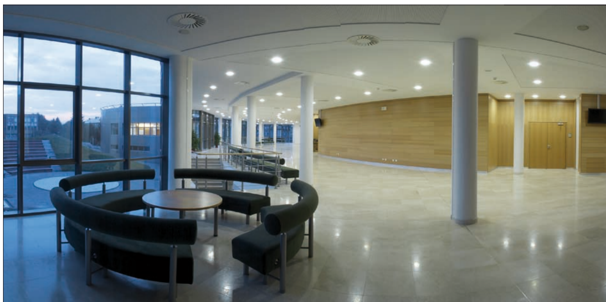
Obr. 5. Osvětlení chodeb – svítidla Targetti CCT Flash
