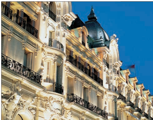
Obr. 1. Fasáda s výbojkovými svítidly
