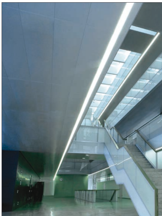
Obr. 7. Vestavné svítidlo Frame – zdůraznění geometrie prostoru
