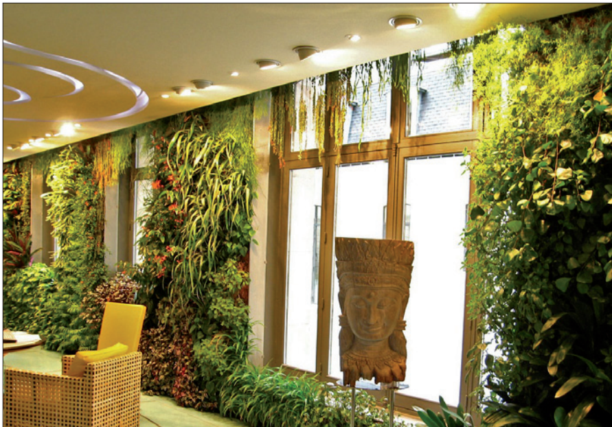
Obr. 3. Osvětlovací soustava vertikální zelené stěny s vestavěnými stropními svítidly (Club Med, Paříž)
