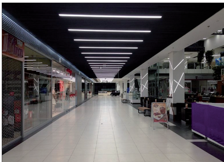
Obr. 3. Svítidla Idaho LED v lamelovém podhledu ZOC MAX Poprad
