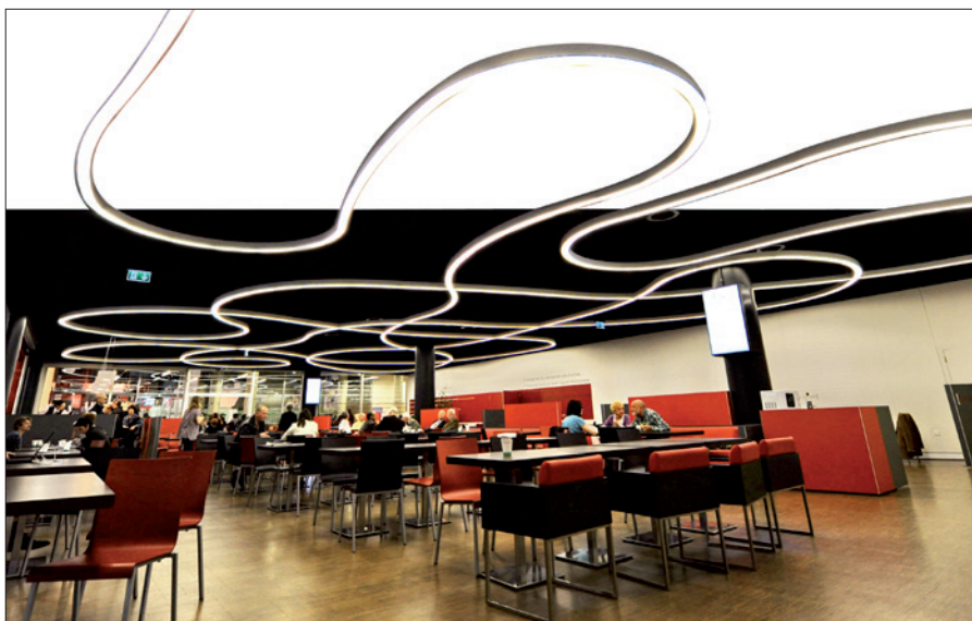
Obr. 3. Klikaté světelné linky projektu Spaghetti byly pro zkušenou konstrukční kancelář Lumi-verre skutečnou výzvou; mimořádně obtížné bylo dokonale slícovat různé přechody a křížení jednotlivých částí svítidel
