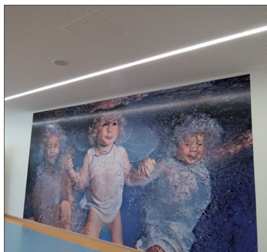
Obr. 5. Vestavné liniové osvětlení probíhá v celé délce oddílu pro rodiny s malými dětmi
