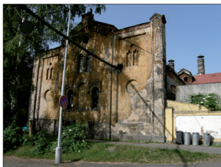
Obr. 2. Štít sladovny před rekonstrukcí
