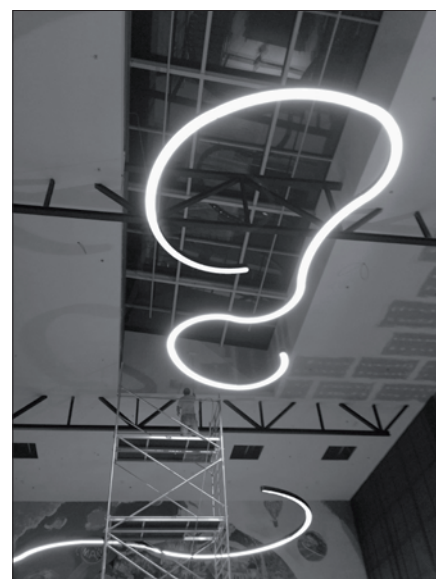
Obr. 7. Svítidlo Super-G během instalace v hlavním vstupu ZOC MAX Trenčín
