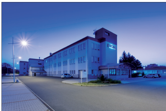
Obr. 1. Budova výrobního závodu ROBE Lighting ve Valašském Meziříčí
