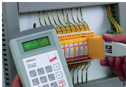
Obr. 5. Funkce LifeCheck informuje o stavu datové přepětové ochrany
