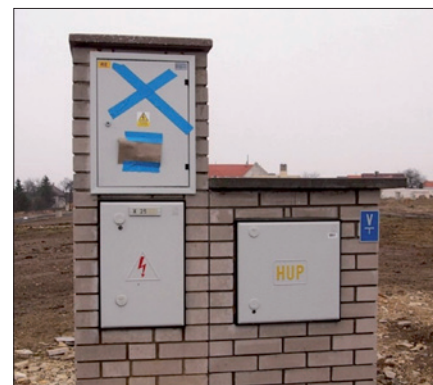
Obr. 4. Neschválená stavba sloupku ER
