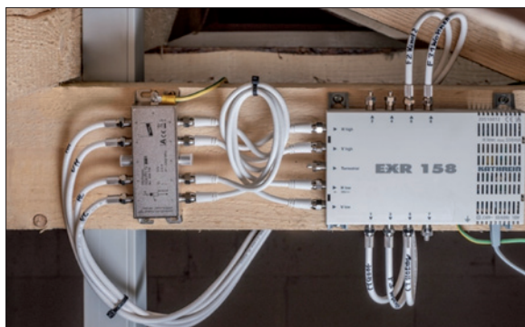
Obr. 3. Příklad ochrany koaxiálního vedení na vstupu do objektu
