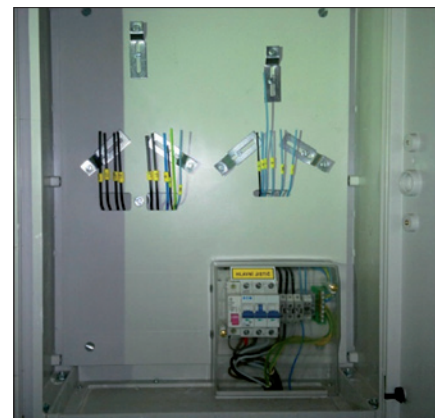
Obr. 7. ER před osazením elektroměru a HDO
