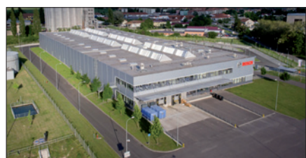
Obr. 1. Servisní středisko Bosch v Mikulově
