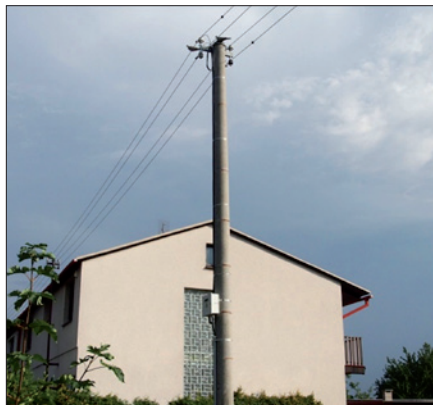
Obr. 5. Připojení z venkovního vedení
