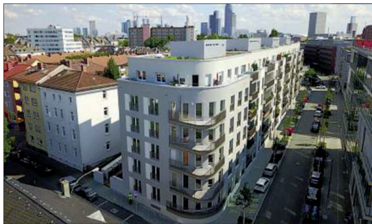
Obr. 2. Při výstavbě vícepodlažních domů může standard pasivního domu dosáhnout téměř stejných nákladů jako u konvenční výstavby
