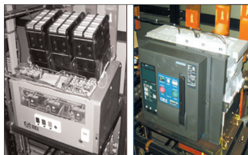
Náhrada jističe AR2533 jističem ARION WL1225
