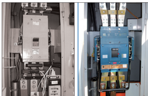
Náhrada jističe J2Z75T242 jističem BL1000SE305
