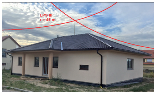
Obr. 7. Instalace vodiče HVI light na střeše dřevostavby
