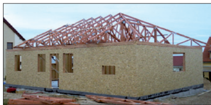
Obr. 2. Výstavba rodinného domu z dřevěné konstrukce
