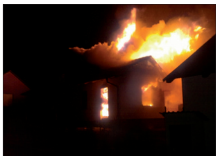
Obr. 1. Pohled na vyhořelou dřevostavbu
