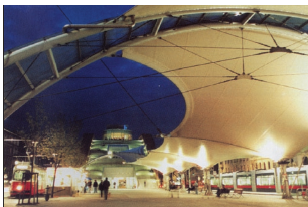
Obr. 3. Originální zastřešení stanic veřejné dopravy před novou městskou knihovnou ve Vídni
