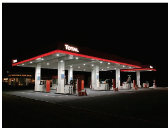
Obr. 5. Použití řetězců powerLED chain P510 red pro vnitřní osvětlení pásu atiky
