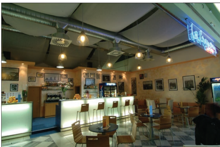
Obr. 3. Kavárna La Creperia osvětlená svítidly Box Archis 14 s průsvitnými reflektory, osazená kompaktními zářivkami 23 W, bar a zázemí osvětlují obdobná svítidla s hliníkovým fazetovým reflektorem, osazená směšovými výbojkami 160 W
