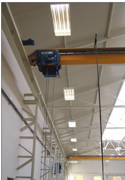
Obr. 1. Osvětlení výrobní haly v Brně svítidly 06/4x 80 W
