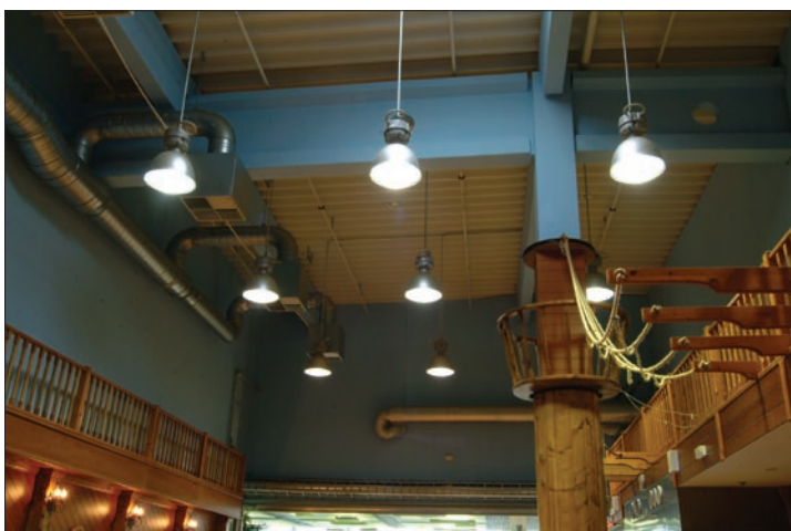
Obr. 2. Pohled na stropní prostor pizzerie s příznou stavební konstrukcí a vzduchotechnikou
