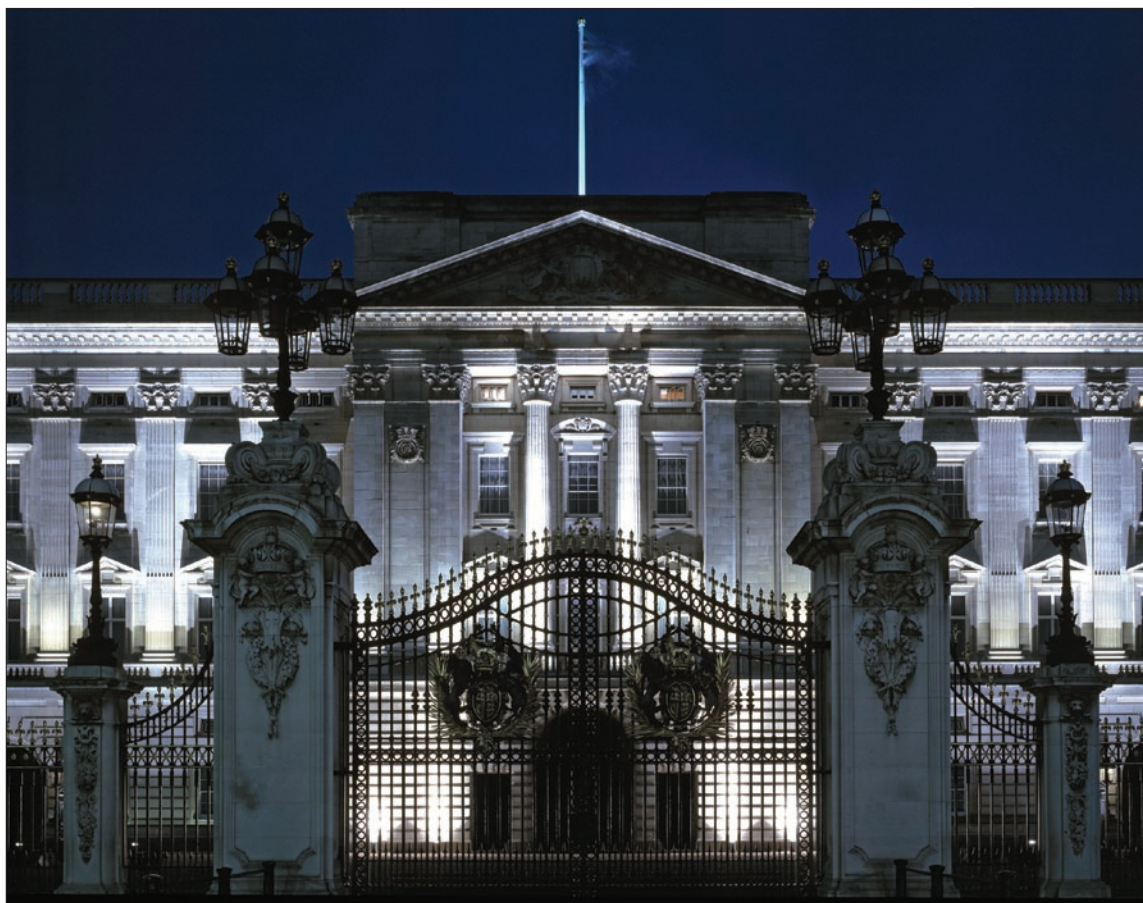
Obr. 2. Buckinghamský palác – osvětlení středové části průčelí
