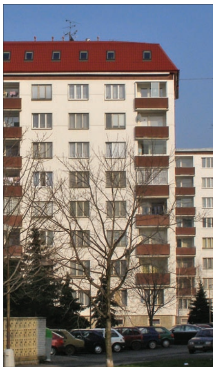
Obr. 1. Střešní nástavba na panelovém domě
