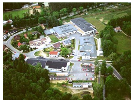
Výrobní závod Moeller Elektrotechnika s. r. o. v Suchdole nad Lužnicí
