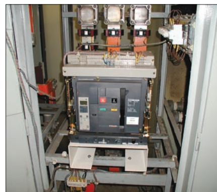
Obr. 4. Retrofit rozváděče nn jističem Masterpact NW 2 500 A
