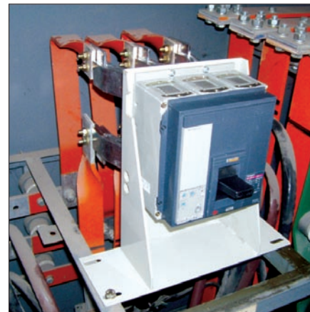
Obr. 3. Retrofit jističe 1 000 A moderním jističem NS1000H
