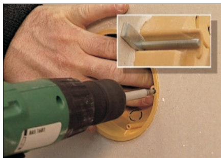
Obr. 2. Uchycení krabice klasickým postupem – šroubek s patkou
