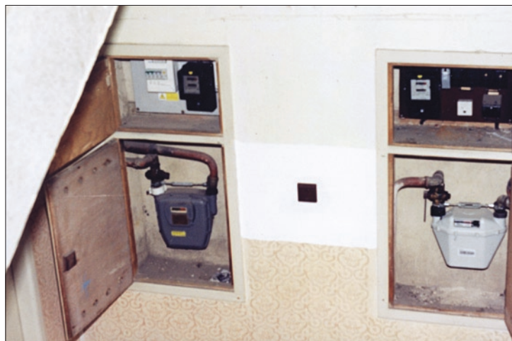
Obr. 1. Elektroměr a jističí prvky umístěné ve společné rozvodnici na chodbě obytného domu
