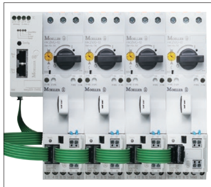
Obr. 2. Moderní a úsporný systém připojování stykačových kombinací k řídicím systémům
