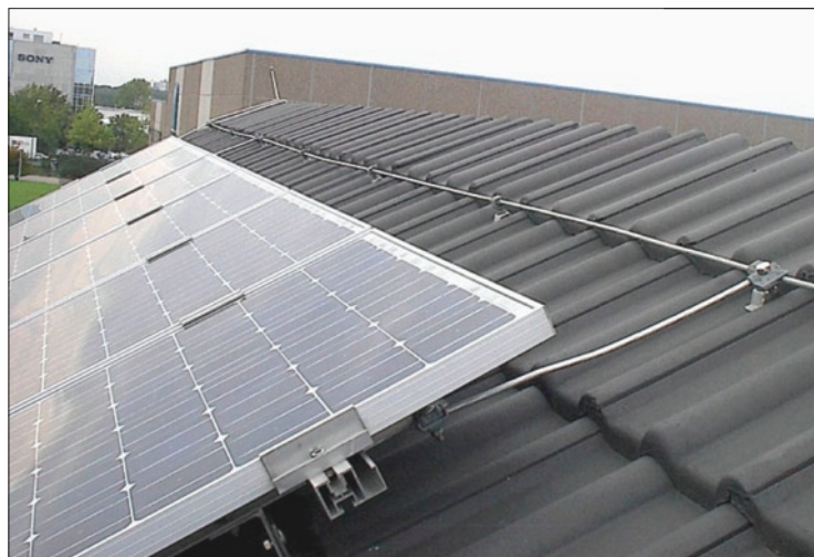
Obr. 6. Kvalitní propojení nosných rámců panelů s jímací soustavou
