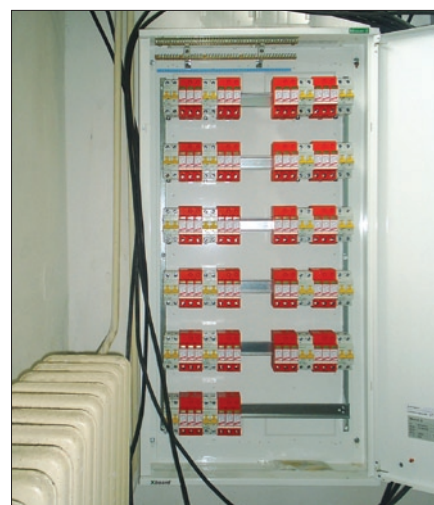
Obr. 3. Varistorový svodič DEHNguard® Y PV 1000 (foto z montáže)
