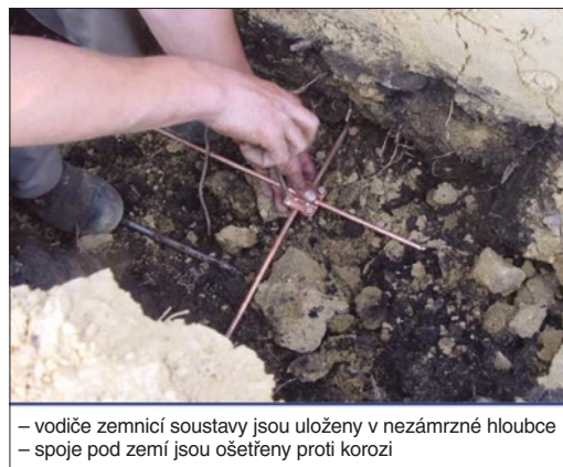
Obr. 5. Příklad instalace mřížové zemnicí soustavy
