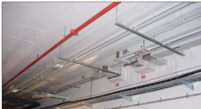
Obr. 4. Pohled na výstup z rozvodny 2x 1 600 A, 2x 400 A
