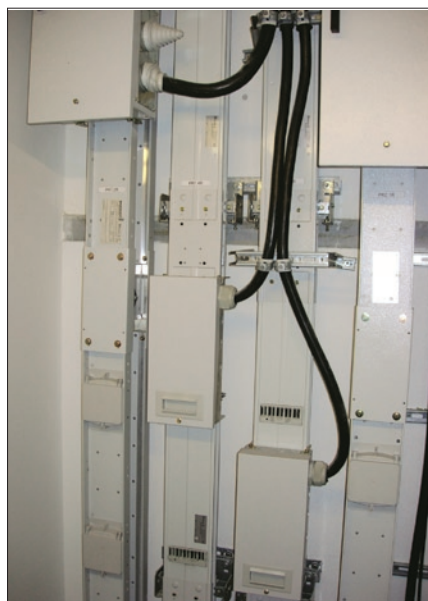
Obr. 2. Přípojnice a odbočné krabice v místě napájení spotřebiče
