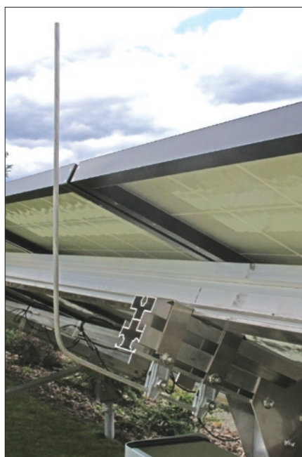
Obr. 2. Vztyčení a uchycení pomocných jímačů na rám
