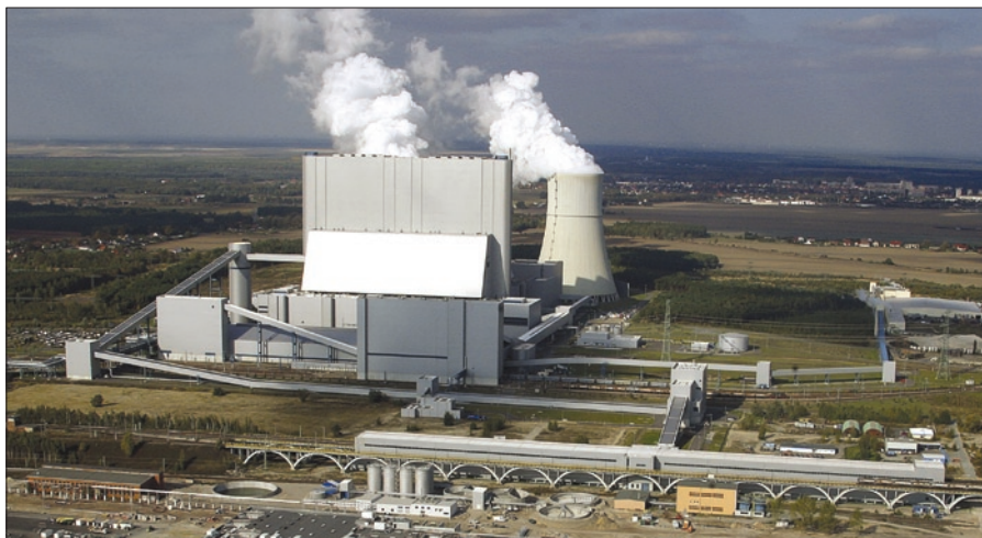
Obr. 1. Hnědouhelná elektrárna Schwarze Pumpe (Německo)
