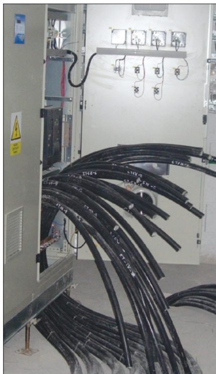
Obr. 3. Pohled na „dno“ rozváděče a množství kabelů, vedoucích k jednotlivým vzdáleným spotřebičům
