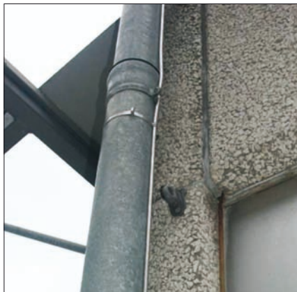
Obr. 7. Svod (přichycený) a schovaný za rourou
