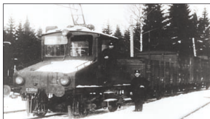
Obr. 7. Lokomotiva řady E 200.0, pravděpodobně už z roku 1903; lokomotiva tohoto typu byla provozována už na trati Tábor–Bechyně; jezdila určitě na trati na trati Rybník (Cetlov)–Lipno a zřejmě i na dalších tratích; tato má zvláštní, „lyrový“ sběrač
