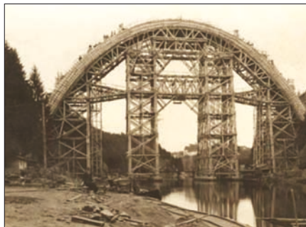
Obr. 11. Křižíkova elektrifikovaná trať Tábor–Bechyně v roce 1903 končila před tokem řeky Lužnice; klenutý železobetonový most byl postaven a trať prodloužena až přímo do Bechyně teprve v letech 1926 až 1928; vozovka i železnice vedou ve stejné úrovni po mostovce, která je ve výšce 50 m nad Lužnicí
