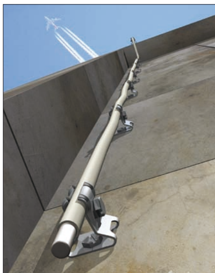
Obr. 5. Přichycení DEHNALU drátu s PVC izolací na stěny svorkami
