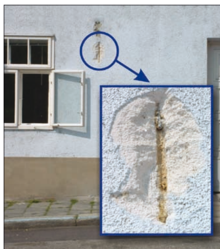
Obr. 1. Holý drát AlMgSi poškozený chemickou reakcí
