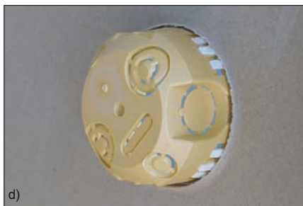
Obr. 2. Použití originálního nářadí a montážního kroužku šetří čas při instalaci
