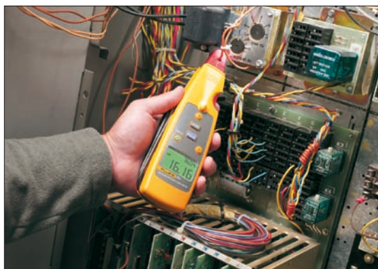
Obr. 2. Měření v rozváděči
