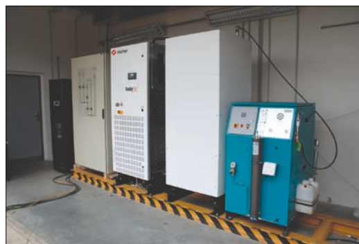
Obr. 5. DC 2 ® ve zkušebně Phoenix-Zeppelin (zprava kompresor, skříň s tlakovými lahvemi, CoolAir, záskokový rozváděč a zdroj UPS)
