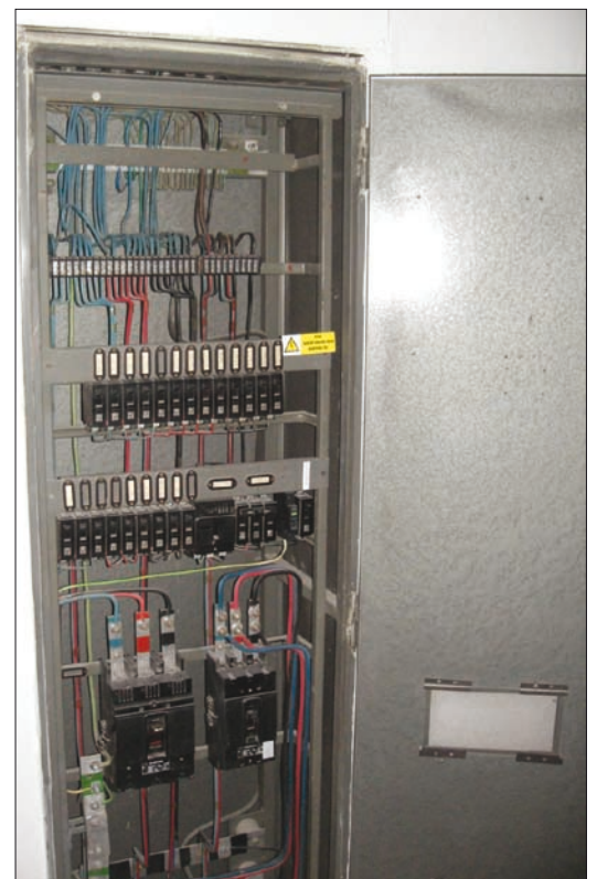
Obr. 1. Starší rozváděč s běžným provedením elektroinstalace
