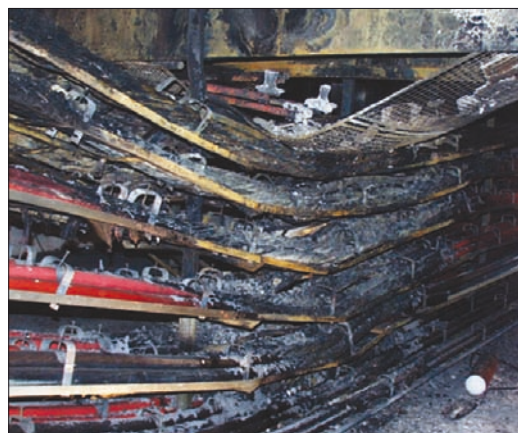
Obr. 3. Následky požáru kabelového vedení
