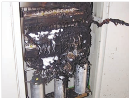
Obr. 2. Požár malého distribučního rozváděče
