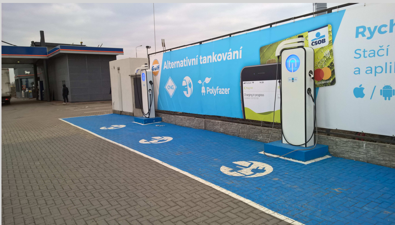
Čerpací stanice Gulf, ul. Průmyslová, Praha
