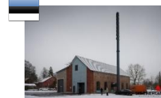
Kotelna na biomasu, Kohila Estonsko
