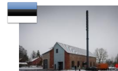
Kotelna na biomasu, Kohila Estonsko
