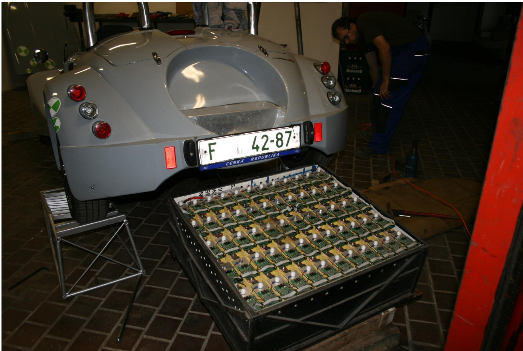
Obr. 40 K1 před vestavbou opraveného zadního akumulátorového packu (2011)
