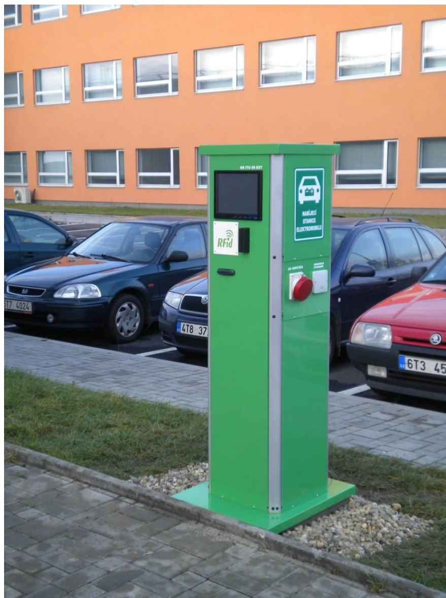
Obr. 32 Veřejná nabíjecí stanice VŠB-TUO a její umístění vedle Prototypové laboratoře CPIT v areálu VŠB-TUO v Ostravě Porubě (od 2011).
